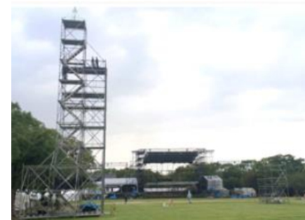
照明用トラスタワーへの設置
